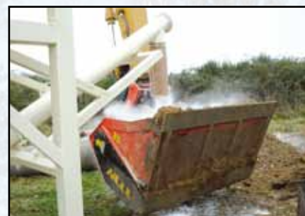
Stabilisering af jord med kalk
