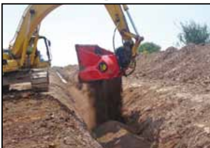
Tilbagefyldning ved rørlægning
